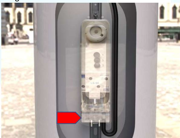
Stap 5. Sluit de voedingskabel aan op het hoofdnet (fagetkast).
